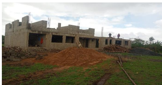
De bouw van onze opvang is begonnen...
